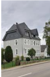
Foto: "der Dachdecker" Fischer GmbH
