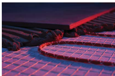
Foto: Herotec Flächenheizung GmbH, Ahlen
