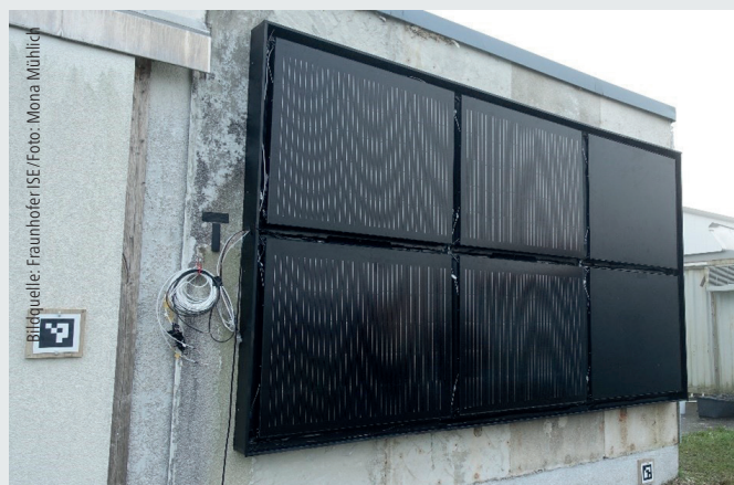
Demonstrations-Installation von sechs Fassaden-Photovoltaikelementen am Standort des Fraunhofer IBP. Die 1 mal 1,2 Meter großen PV-Elemente lassen sich beliebig erweitern, bei Bedarf farbig gestalten und sind schnell installiert.
