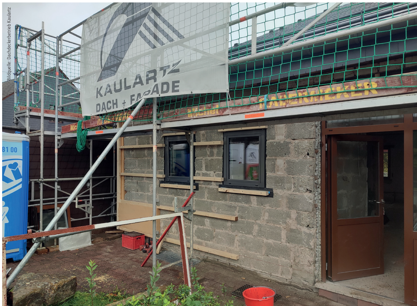
Für die Aufnahme der ersten Dämmlage montierten die Dachdecker von Kaulartz die 8/8-Kanthölzer waagrecht.
