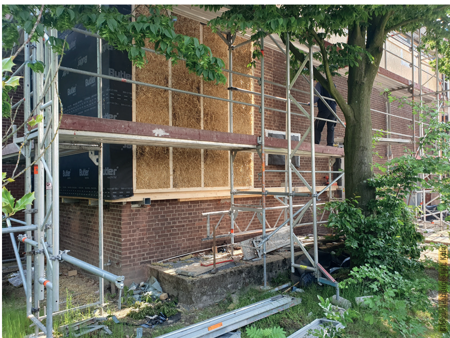
Die Wandelemente stehen auf Tragbalken, die wiederum auf verankerten Hohlprofilen gelagert sind.
