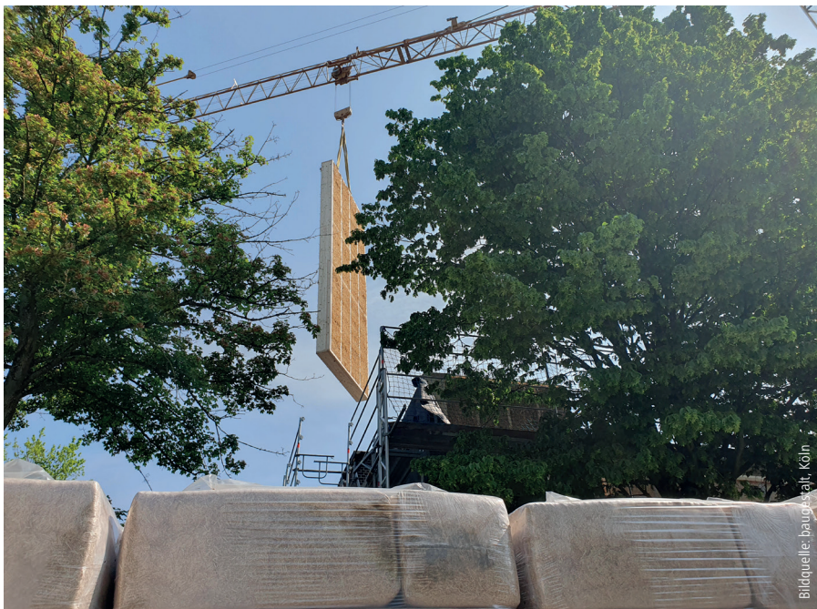
Vorgefertigte mit Stroh gedämmte Wandelemente wurden direkt auf die Baustelle geliefert und verbaut. Die Dächer wurden mit Einblasstroh baustellenseitig gedämmt.
