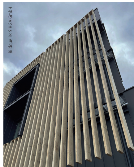
Lamellenfassade aus Holz: Für ein optisch ansprechendes Ergebnis und eine effiziente Montage hat Sihga jetzt den Verbinder „LamellenFix“ entwickelt.
