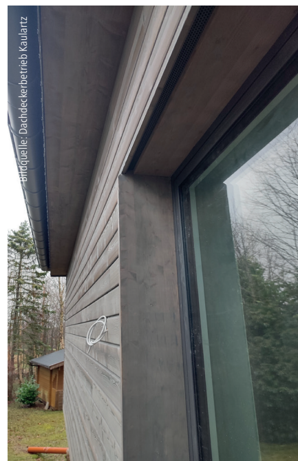
Auch oberhalb des Fensters ist die Belüftungsebene mit einem Lochblech gesichert.
