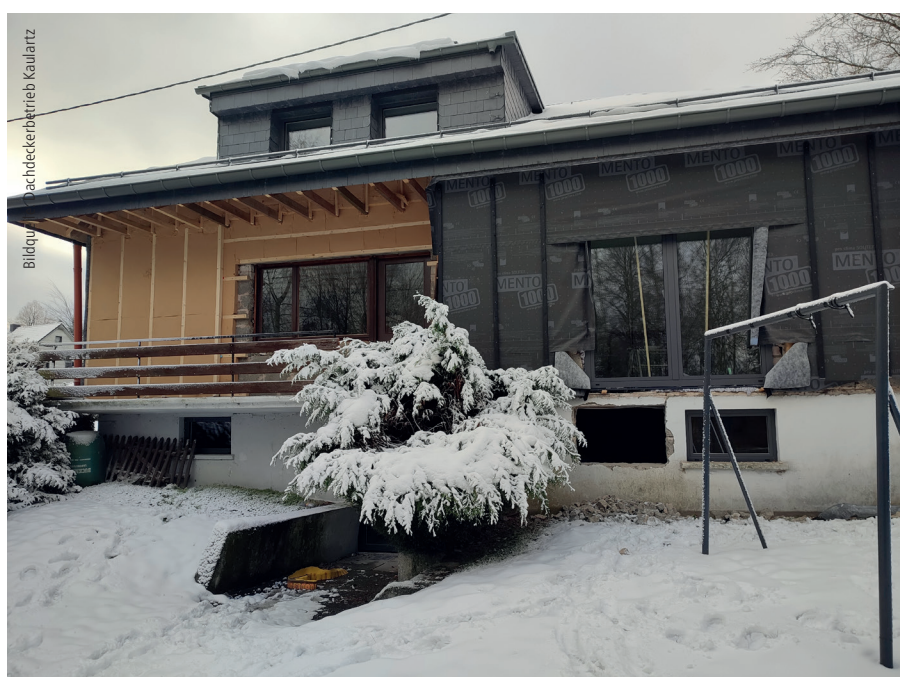
Die zweite 80-mm-Dämmlage wurde zwischen senkrecht montierten Hölzern eingebracht. Die Wandschalungsbahn wurde mit schwarz lackierten Konterlatten gesichert.
