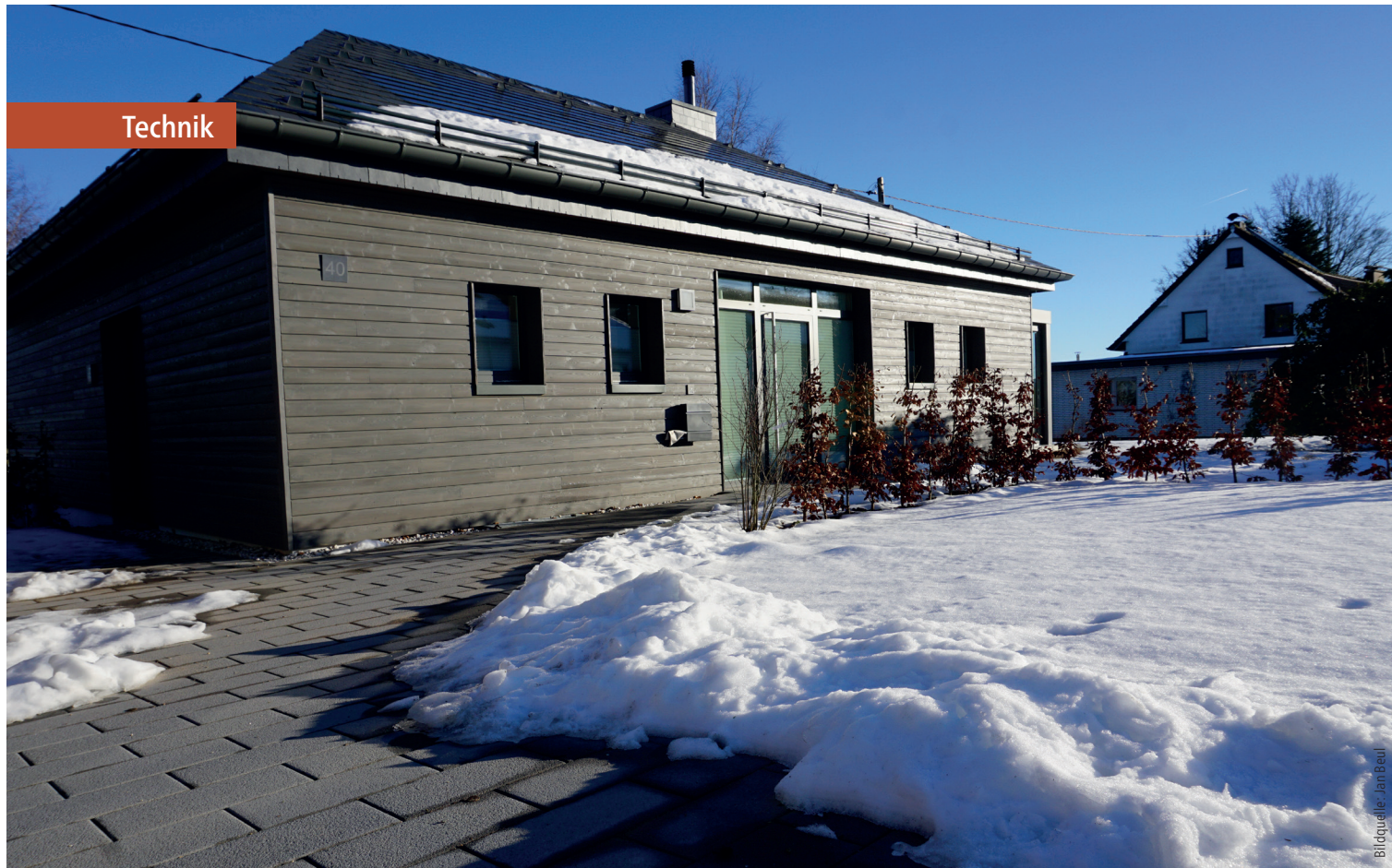
Die natürliche Maserung und die warme Optik von Holz verleihen dem Gebäude einen einzigartigen Charakter.
