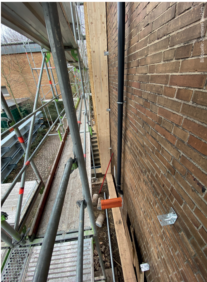
Die Zimmerei befestigte die Elemente mit Winkelverbindern am Bestand. Der Lastabtrag verläuft vor allem über die Tragbalken an den Fußpunkten der Elemente.
