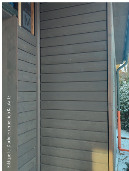
Die Nut-Feder-Verbindung sorgt für ein gleichmäßiges Deckbild.
