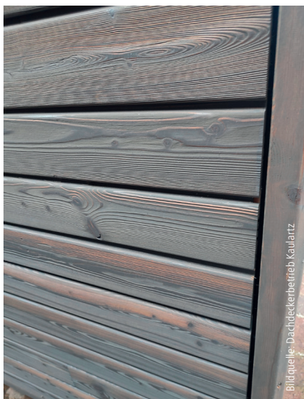
Die Dachdecker achteten auf eine millimetergenaue Eckausbildung.
