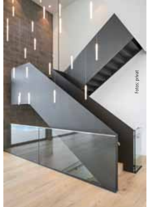
Die geländerhohen Wangen bestehen aus Stahlblech, das von der Decke abgehängt ist, der Handlauf ist aus Eichenholz gefertigt und die Brüstungsgeländer wurden aus eingespannten Glasscheiben mit Kantenschutz aus Edelstahl-U-Profilen gestaltet.
