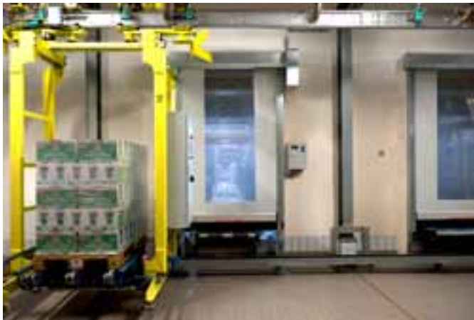
Alle Produkte, die in den drei Hochregallagern mit insgesamt 20.000 Palettenstellplätzen deponiert werden, werden durch Tore von Efaflex geschleust.
