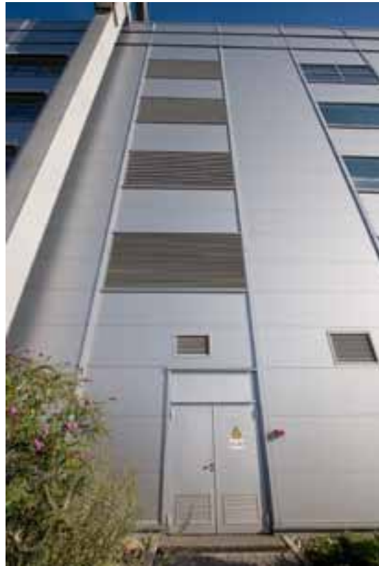
Den Gipfel der Luftdurchlässigkeit repräsentiert der Lüftungsgittertyp „High-flow“, der mit einer Luftdurchlässigkeit von 60 Prozent für eine Airbus-Produktionshalle in Hamburg eingesetzt wurde.
